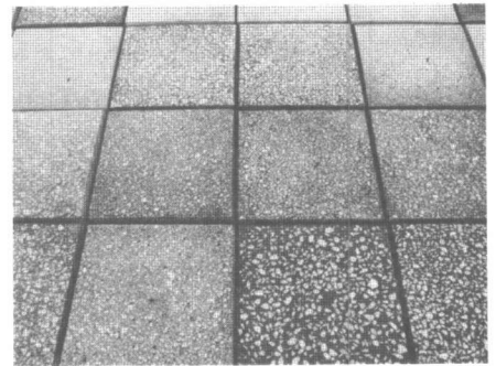
写真-1 ポリマー含浸セッコウタイルを施工した床
