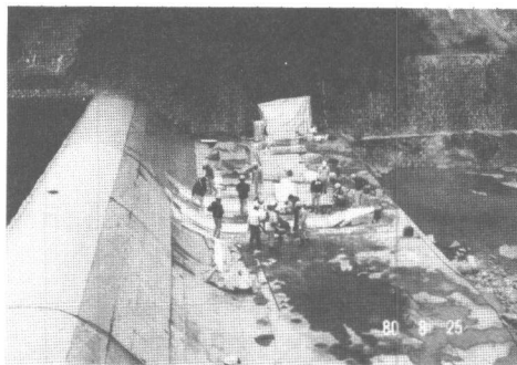
写真-7 ポリマー含浸施工中の現場
