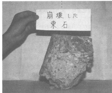
写真-2 崩壊した東石の状況
