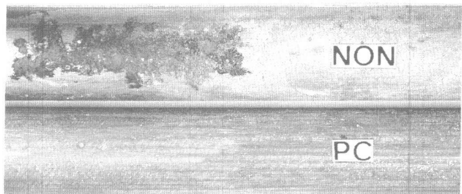
写真5 4年間暴露後の鉄筋（かぶり厚さ30mm）
