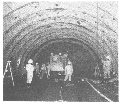
写真-3 低粉じん型の吹付け施工
