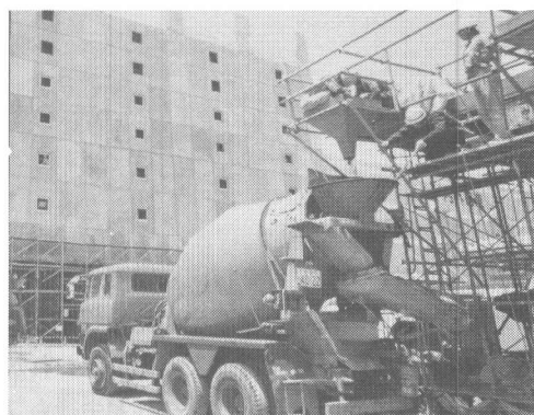
写真-1 鋼繊維投入用架台
