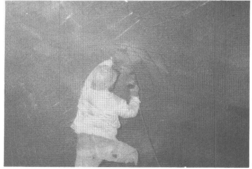
図-2 吹付けコンクリート用補強網の取付け状況
