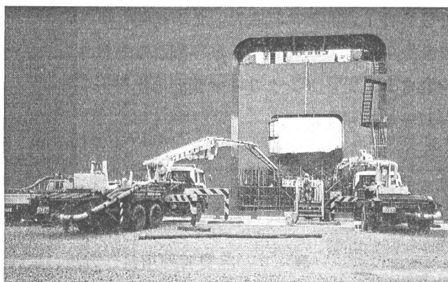
写真-2 ポンプ車の配置状況
