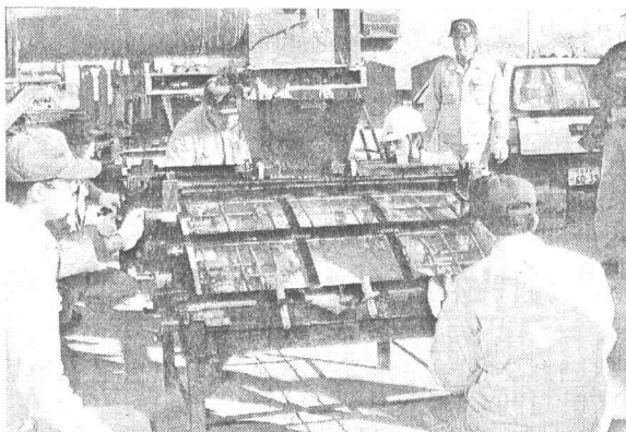
写真-1 平打ち状況
