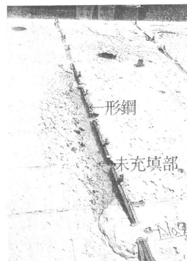
写真-1 未充填部発生状況
