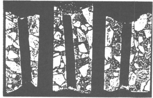
写真-3 ドリルによる削孔状況
