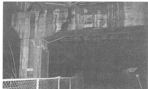
図-9 Cランク橋脚の損傷状況 (表-2の⑩)
