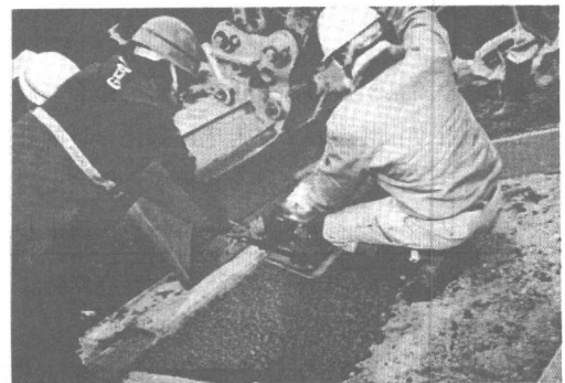
写真一2 締固め状況（重力方向）
