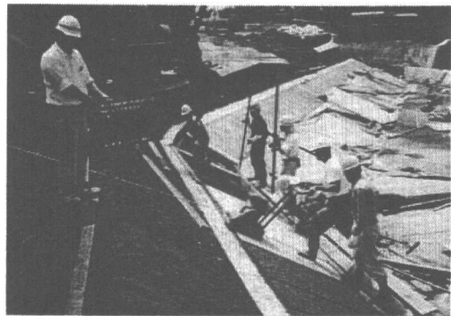
写真-3 施工状況
