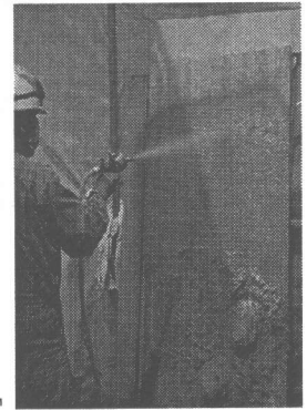
写真-1 吹付け施工状況
