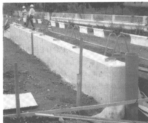
写真-7 完成した擁壁
