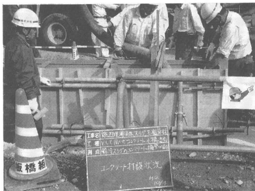
写真-6 コンクリートの打込み状況
