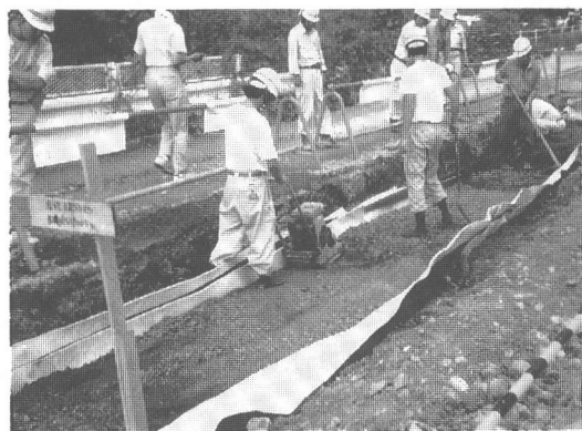
写真-4 基礎材の施工状況
