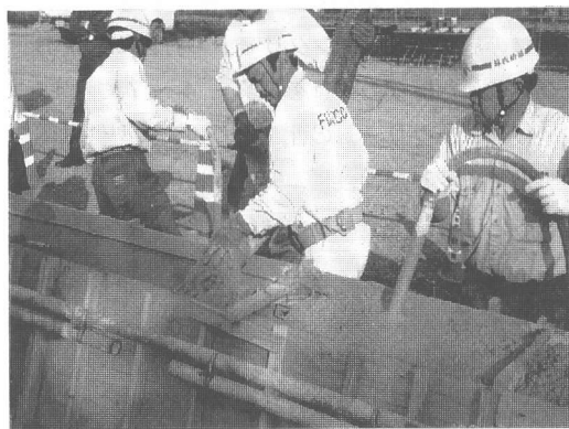
写真-5 コンクリートの打込み状況
