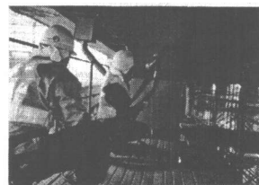
図一八 素地調整工の様子
