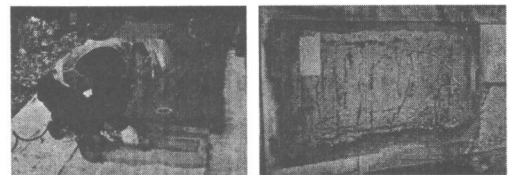
図-3 ディスクサンダーによる施工 (No. 5)
