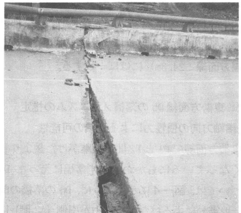
写真-8 卓欄線 P1 上のけたの回転変位
