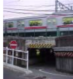
図-4 漏水している部材の全景
