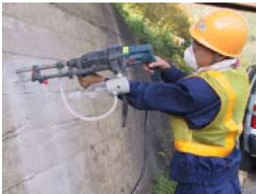
(b)集塵タイプのドリルに専用の試料収集装置を備えたもの
