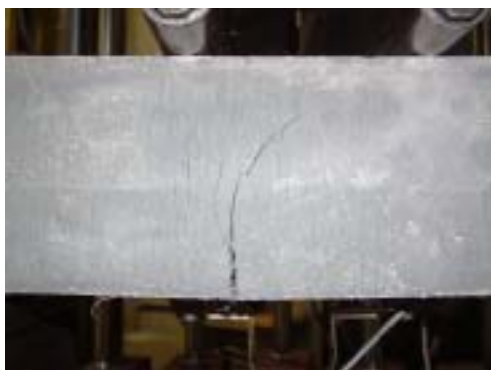
写真 - 3 ひび割れ発生状況
