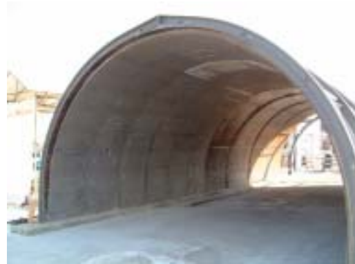
写真 - 6 施工後全景
