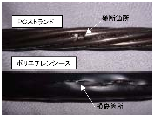
写真-3 素線破断と被覆損傷状況
