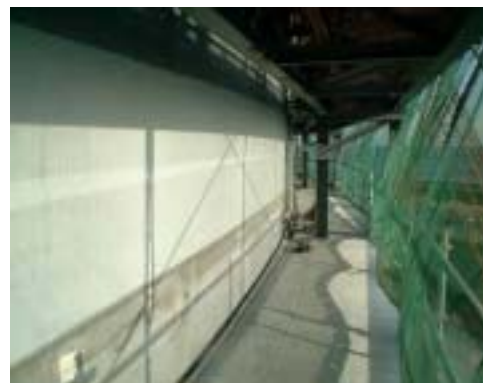
写真 - 3 保水テープの適用状況(その1)
