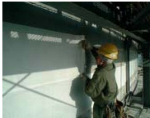
写真 - 2 保水テープの貼付作業状況
