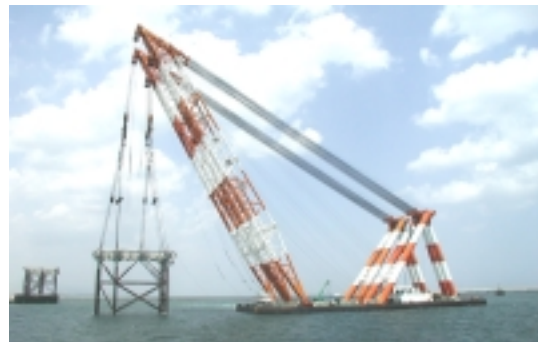
写真-5 ジャケット据付状況
