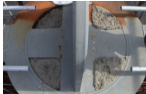
写真-4 CFTコンクリート打ち上がり状況
