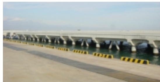
写真-6 ジャケット栈橋現況
