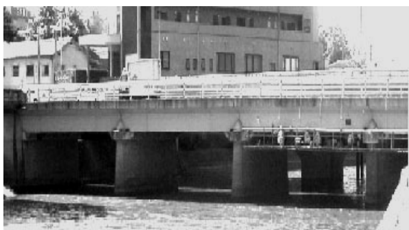
写真-1 橋梁全景
