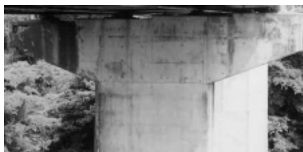
写真-1 A橋橋脚(P2)の外観
