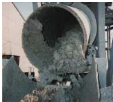
写真-3 コンクリートの搬出状況
