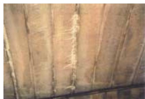
写真-3 漏水・遊離石灰
