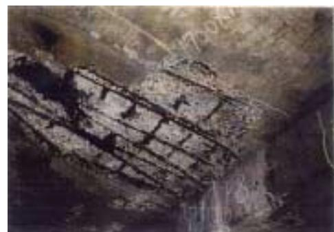
写真-2 鉄筋の露出
