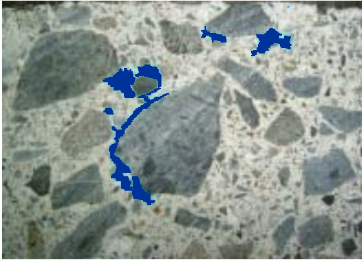
写真-3 コンクリート試験体水平切断面の着色状態 (着色部分をトレース)
