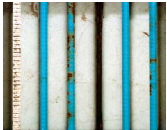
写真-3 暴露鉄筋の腐食状態(暴露5年)
