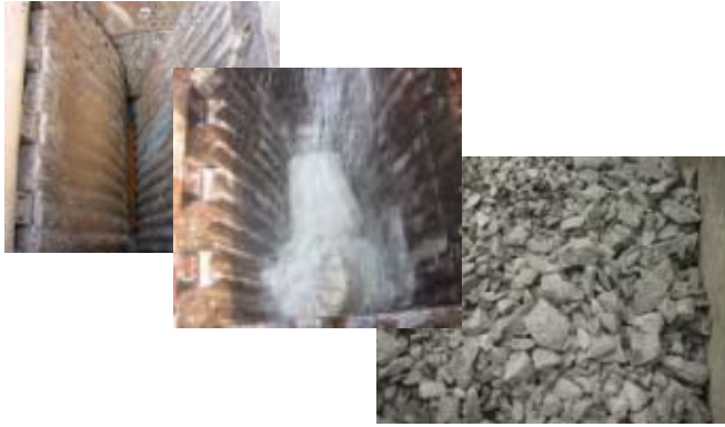
写真-1 コンクリート塊の破碎状況
