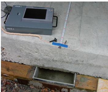
写真-2 水部状況
