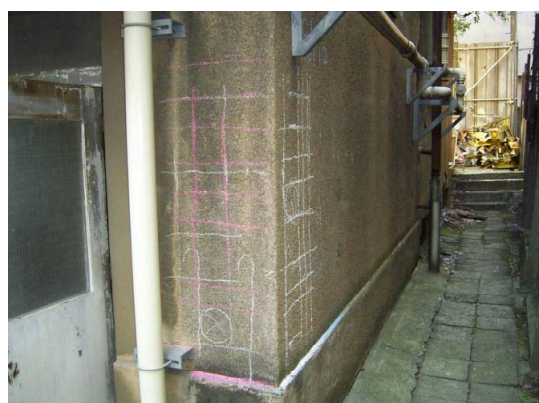
写真-1 1F柱配筋 (大塚)
