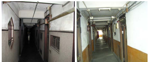
左：江戸川 江戸川（壁・天井漆喰、腰壁洗出し仕上げ） 右：大塚 大塚（壁・天井漆喰、腰壁モルタル下地塗）
