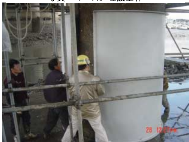
写真-5 型枠設置状況
