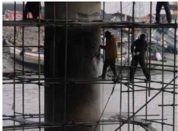
写真-3 表面処理 (WJ) 状況
