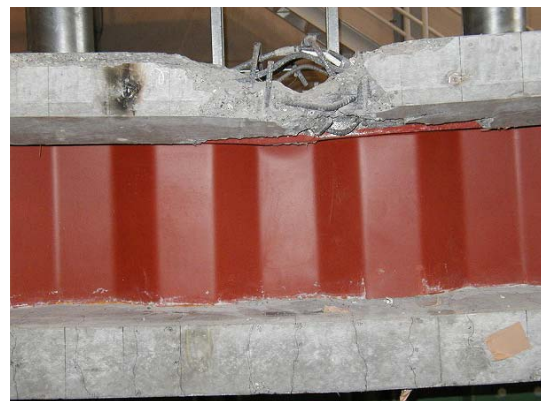
写真 - 3 破壊状況（支間中央）
