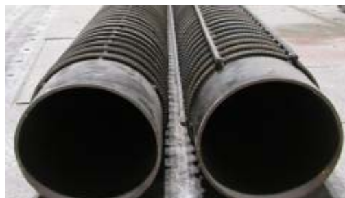
写真-1 鋼管配筋状況
