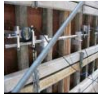
写真-2 変位計測装置の設置状況
