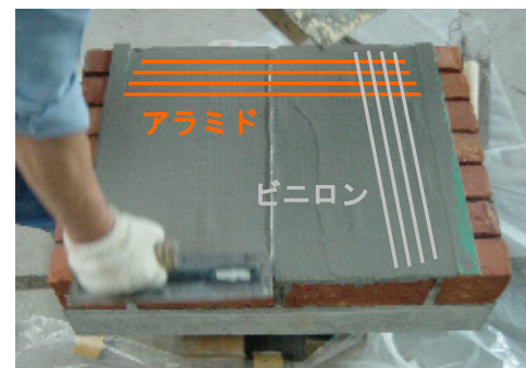
写真-2 施工状況と繊維の方向
