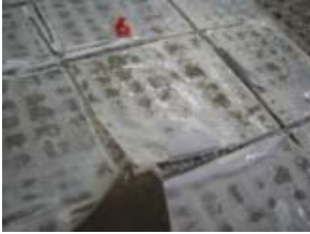
写真-5 凹凸面(L-3)と FRP シート
