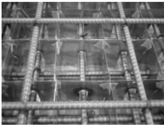
写真 - 1 ステンレス板配置
