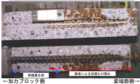
写真-1 鉄筋腐食状況 (D4)
