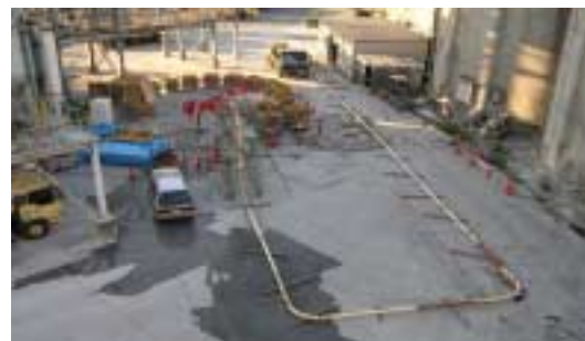
写真 - 1 配管状況写真
