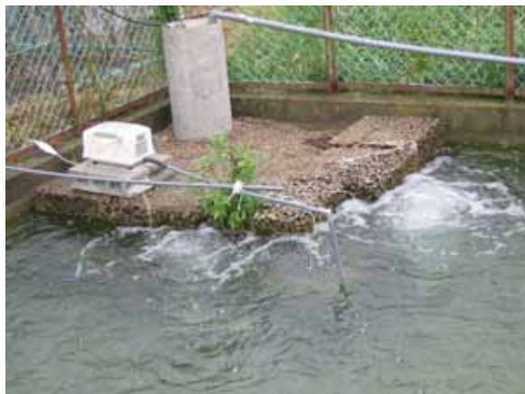
写真 - 3 水質浄化システム設置後の本宮町内の防火用水池
