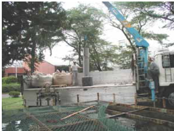
写真 - 2 水循環用ポンプ槽の設置状況
