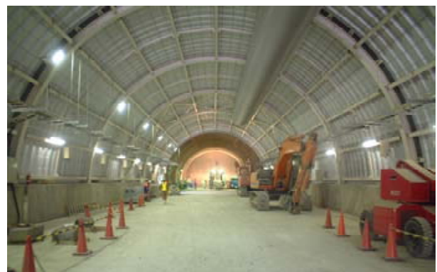
写真-1 模擬トンネル内部の状況
