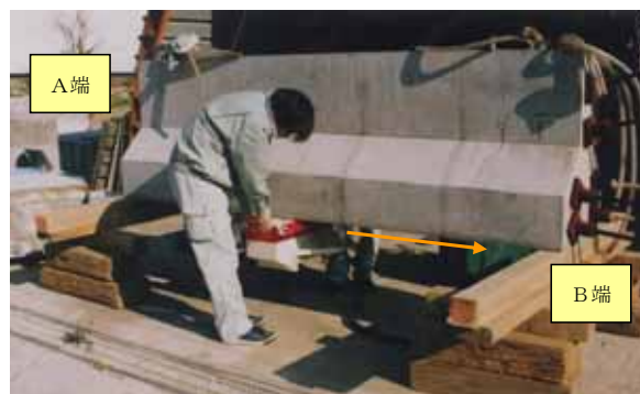
シース4および6の測定状況
