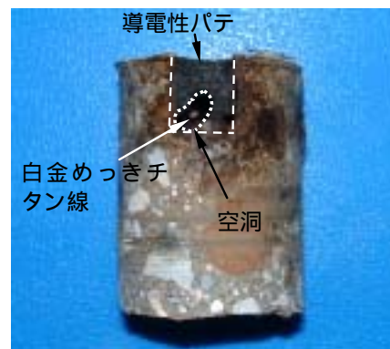
写真 - 1 陽極材付近の断面 (带状陽極方式)
