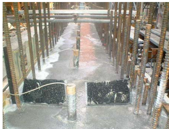
写真-2 鉛直パイプクーリング施工状況
