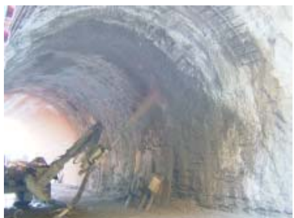
写真 - 1 模擬トンネルでの吹付け状況
