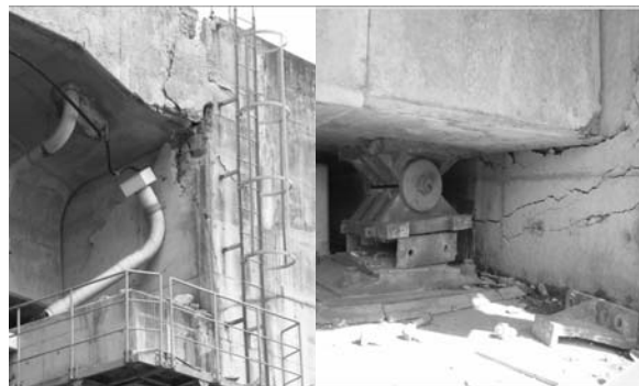
(a)パラペット部 (b)可動支承部
