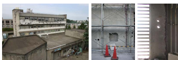
写真-1 5号館と西側局部破壊試験適用状況
