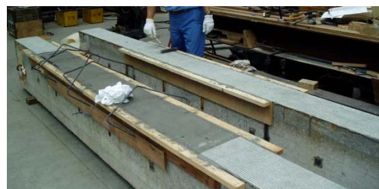
写真-2 表面被覆メッシュ施工状況 (手前：ケース4)
