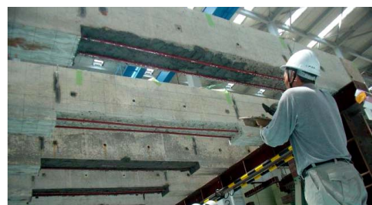
写真-1 断面修復の上向き施工状況
